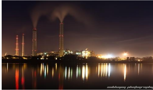
Fig 1.5: Kota thermal power plant
